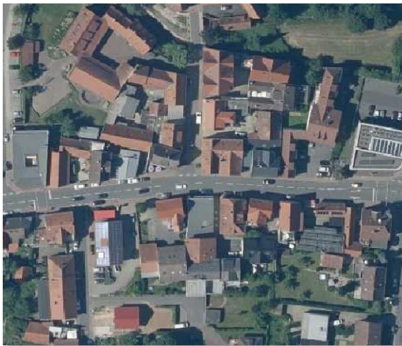
Abbildung 38 | Dichte Bebauung entlang der Ortsdurchfahrt Heidelberger Straße/ Darmstädter Straße (Quelle: Eigene Darstellung DSK nach Daten des Geoportals Hessen)
