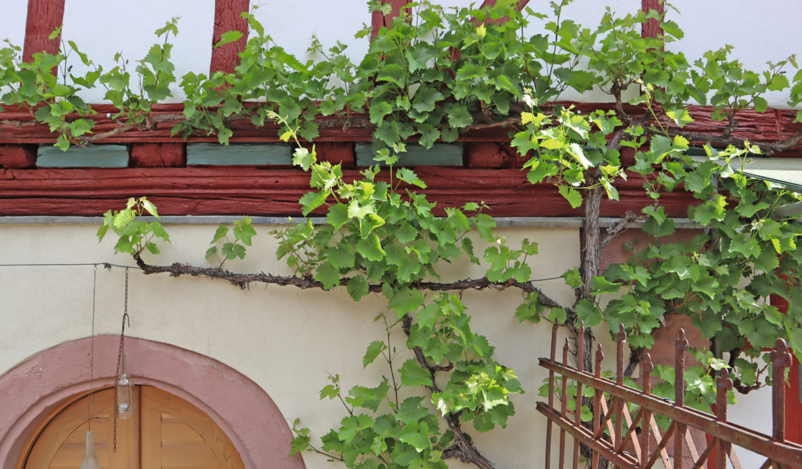
Fassadenbegrünung belebt die Fassade und den öffentlichen Raum
