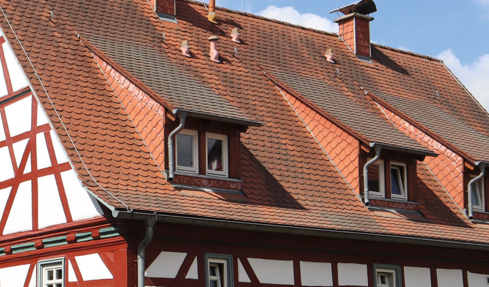
Schleppdachgauben fügen sich gut in die historische Dachfläche ein
