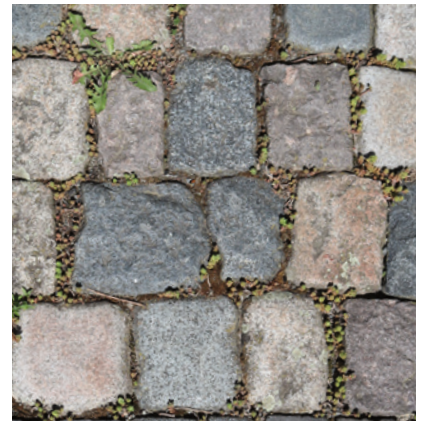
Mittel- / Großsteinpflaster aus Naturstein
